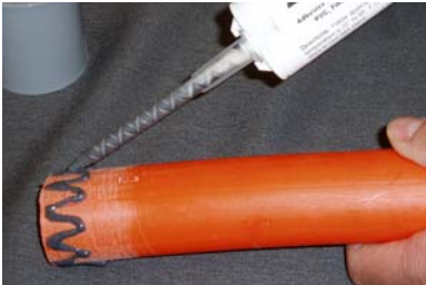
Apply BonDuit® Adhesive
